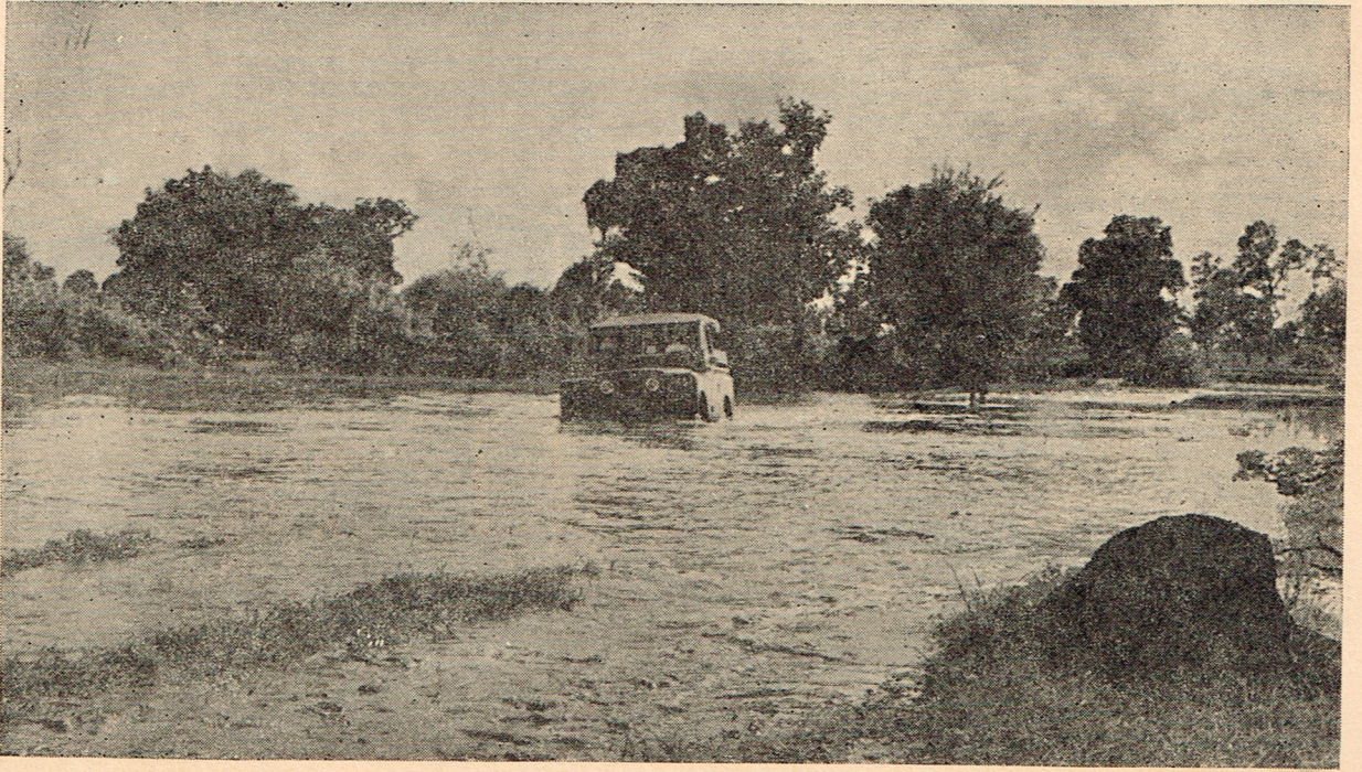
Khon Kean - Yang Talad before Construction
